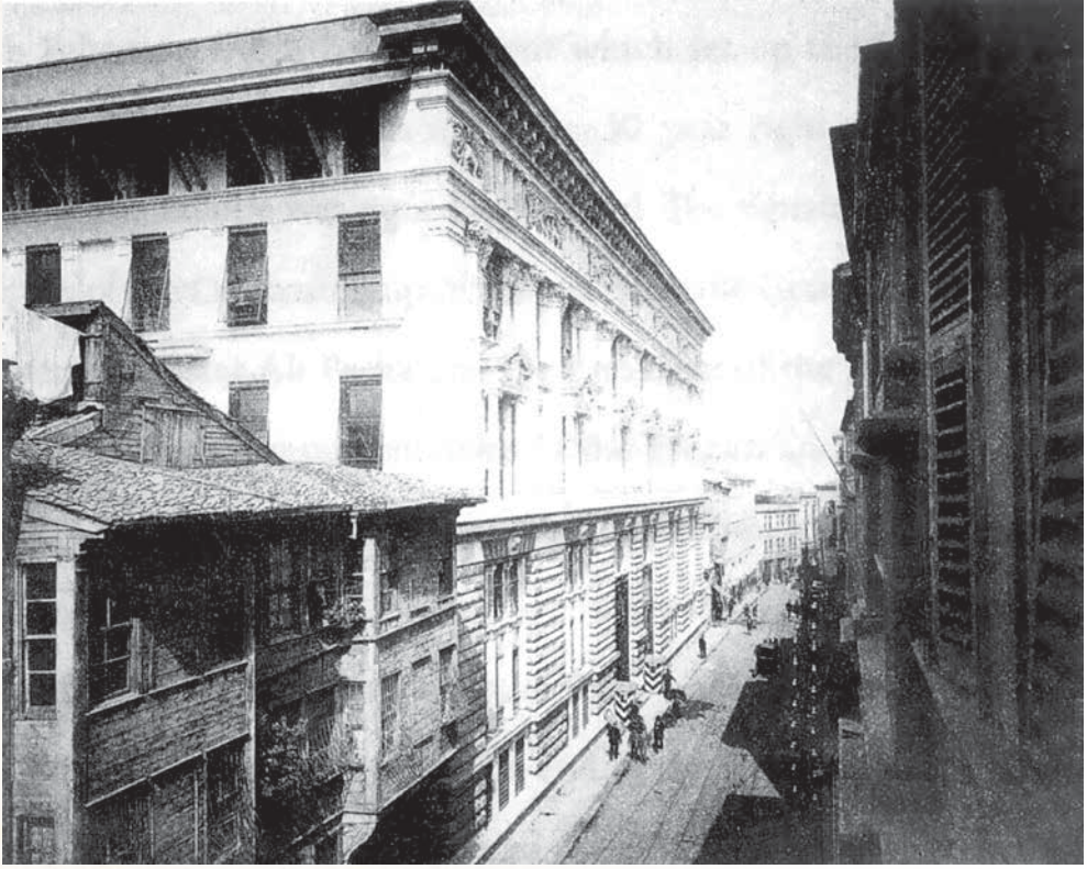
■ Bankalar Caddesi; Osmanlı İmparatorluk Bankası binası ve solunda bugünkü İş Bankası'nın olduğu bina, 1900.
