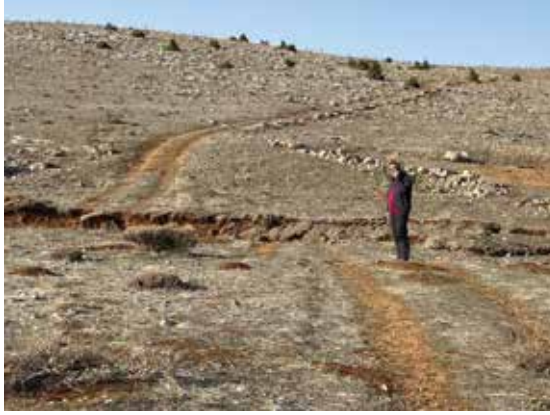
Şekil 3. Sol fotoğraf: Büyük deprem sırasında oluşan yüzey faylanmasına bağlı olarak yolda oluşan hasar. Fayı karşıdan karşıya geçen yol, fayın her iki tarafındaki kabuğun zıt yönlerde hareket etmesi sonucu yaklaşık 5 m ötelenmiştir (6 Şubat 2023 Ekinözü (K. Maraş) depremi). Sağ fotoğraf: Büyük deprem sırasında oluşan şiddetli yer sarsıntısı sonucu oluşan hasar (1999 Gölcük depremi).
