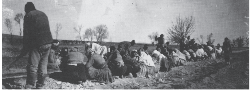
Kurtuluş savaşında demiryolu onarımında çalışan köylüler Eski Bir Şehrin Hikayesi / Doç. Dr. Zafer Koylu - 2015
