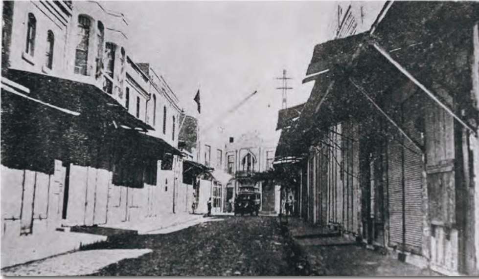
1935' de onarılan Demirciler Caddesi
