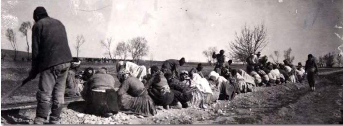
Kurtuluş savaşında demiryolu onarımında çalışan köylüler
