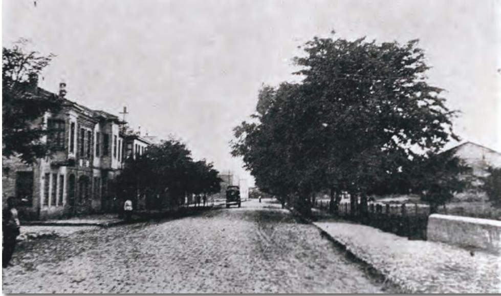
1935'de açılan İstasyon Bulvarı
