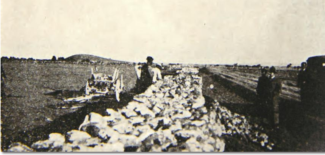
Çukurhisar yolu'nun yapılması
